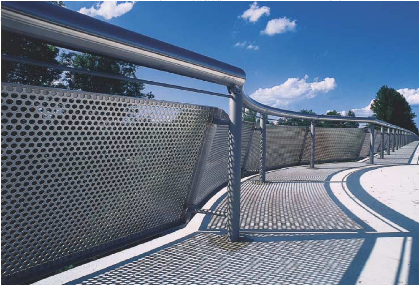
Geländer der neuen Brücke aus Edelstahl
