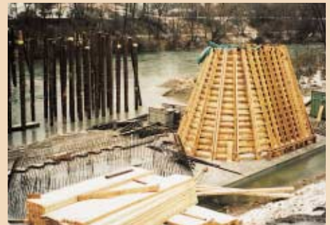
Schalung des Brückenpfeilers
