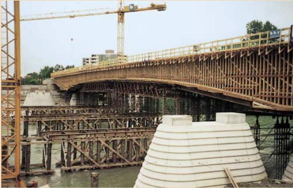
Überbauschalung (südliche Brückenhälfte)
