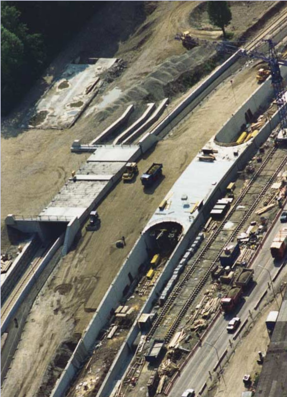
Rohbauten der Unterführung Berliner Allee und der Lokalbahnunterführung
