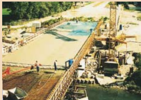
Betonieren der Fahrbahnplatte des südlichen Überbaus
