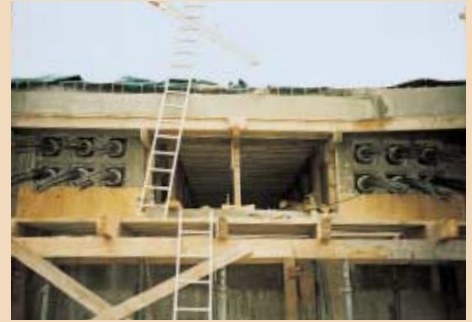
Verankerung der Spannbewehrung im Überbau
