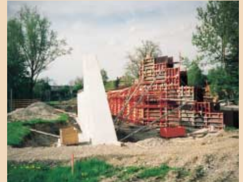
Schalung des Widerlagers und der anschließenden Stützwand der Geh- und Radwegunterführung bei der Schillerschule
