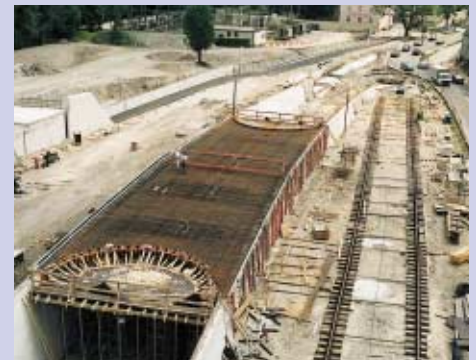
Bewehrung (Armierung) des Brückenüberbaus Berliner Allee
