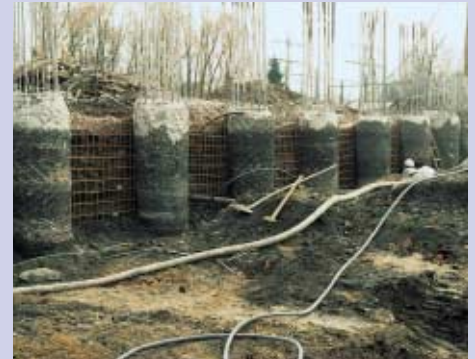
Herstellen der Bohrpfähle für die Unterführung Berliner Allee
