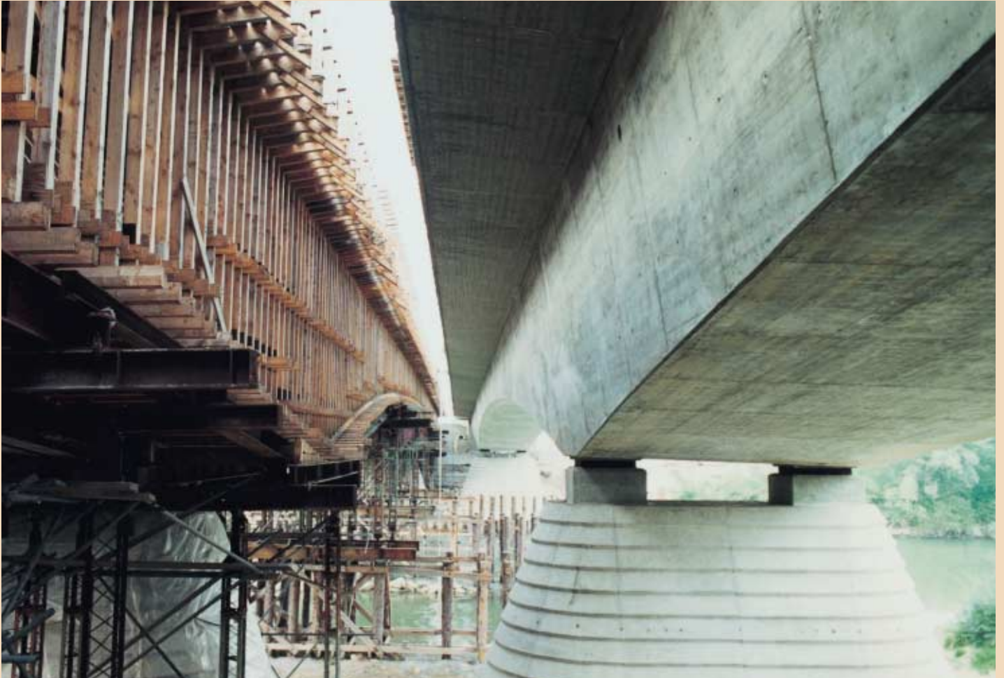
Einschalung der nördlichen Brückenhälfte und Rohbau südliche Brückenhälfte
