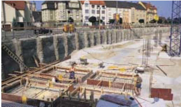
Baufortschritt von 1992 bis 1993
