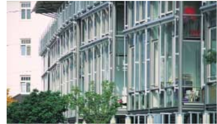
Fassaden mit außenliegendem Sonnenschutz
