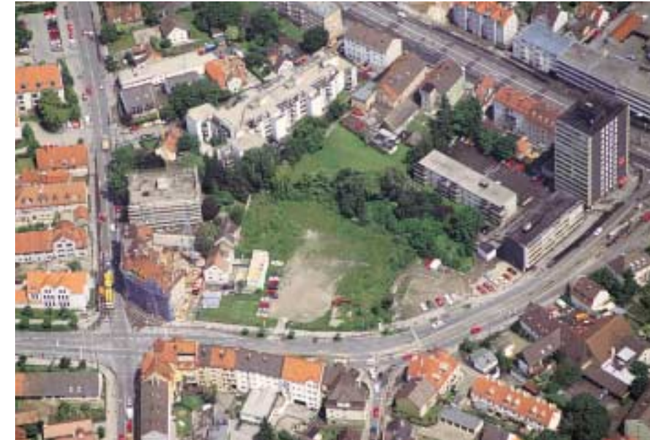
Baulücke an der Kaltenhoferstraße
