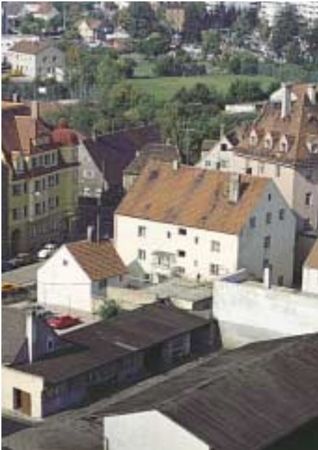
Zustand vor der Betriebsverlagerung
